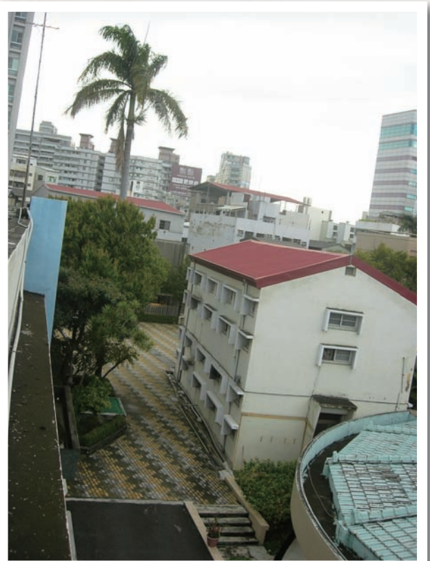
■ 從達德樓頂樓望向幼稚部及黃樓（拆除前為廚房）96.02.09
