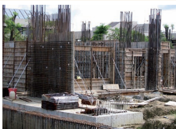
■ 鋼筋及模板施工情形
