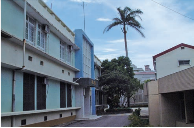
■ 臺南校區側門望向停車場-940807 (左為達德樓，右為黃樓及幼稚部)
