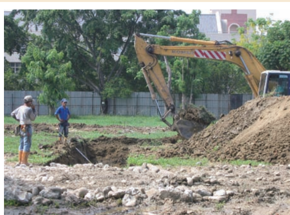
■ 綜合大樓工程基地開挖
