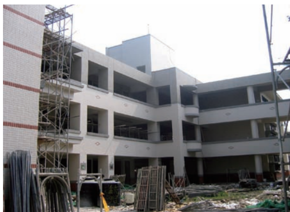
■ 建築物中庭鷹架拆除施工情形
