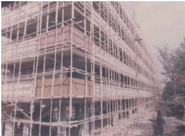
大興土木校舍建築工程
