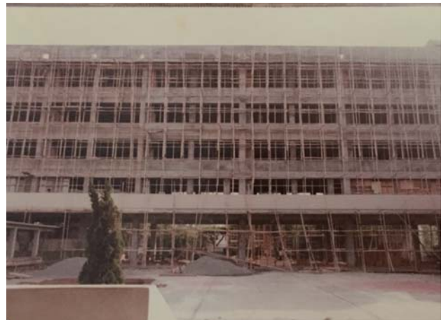
即將竣工的誠敬樓教學教室
