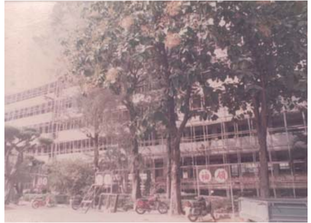
敬誠大樓建築工程
