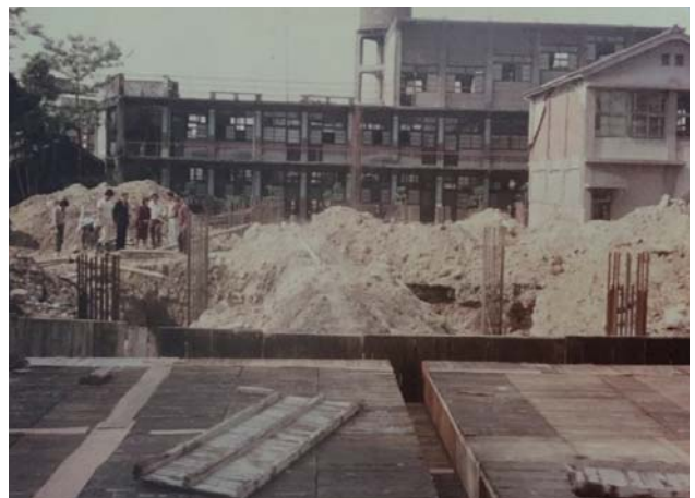
大興土木校舍建築工程
