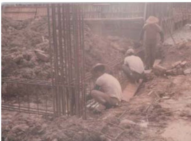
敬誠大樓建築工程
