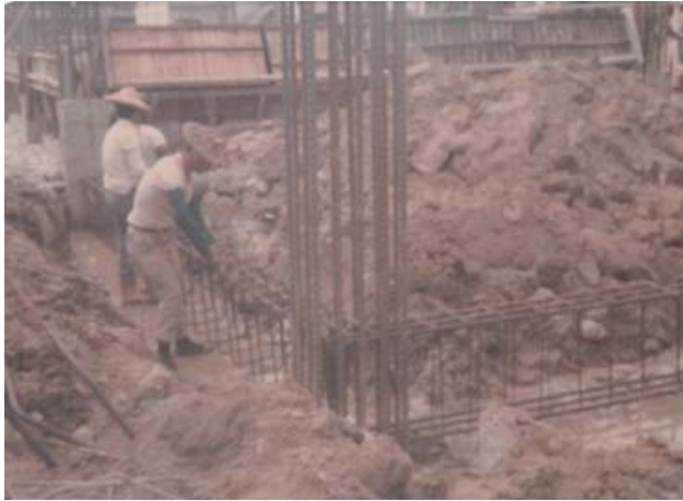
大興土木校舍建築工程
