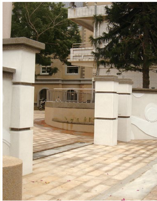
▲西側側門及至善樓周邊鋪設花崗石步道於96年間竣工。
