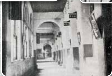
● 舊行政大樓廊道
