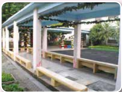
● 連接孝棟舊長廊
