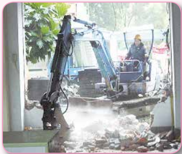
● 教室牆面拆除
