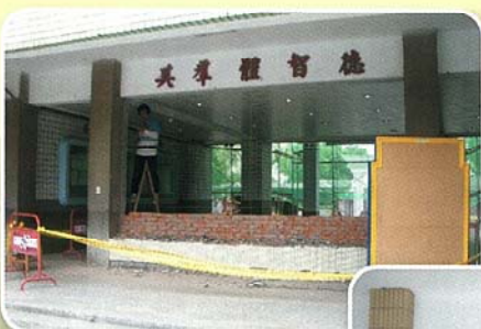
● 城熙牆整修中
