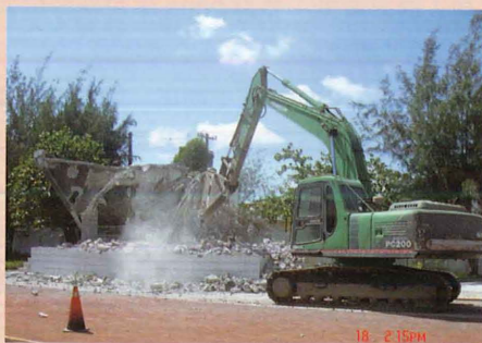
舊校舍司令台拆除了
