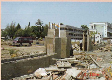
新校舍大門口正在施作
