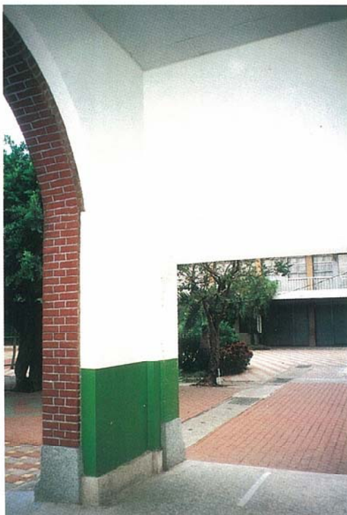
花園樓壁面整修後
