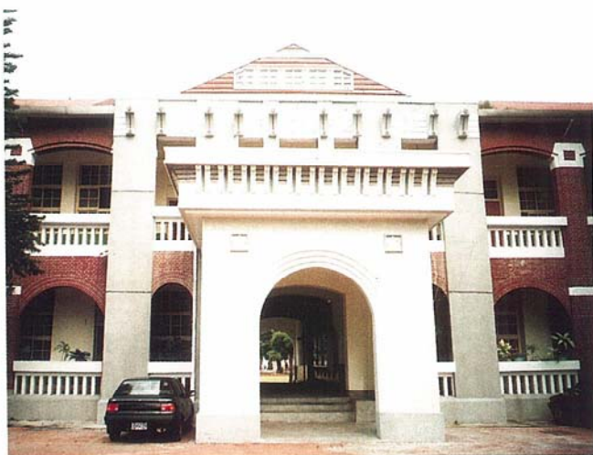
花園樓86年11月整修壁癌及川堂
