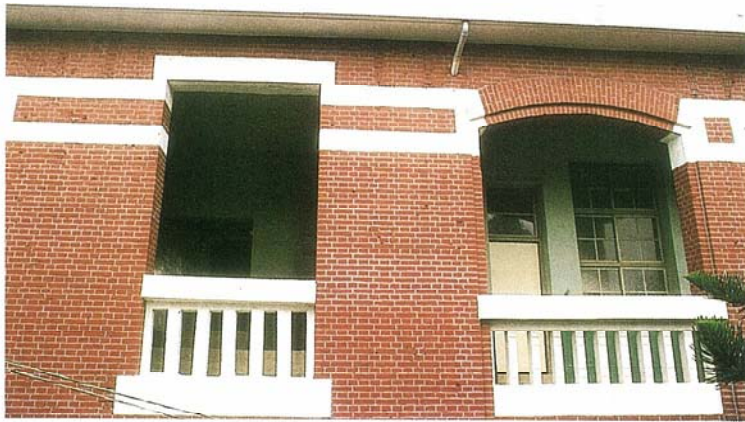
公園國小花園樓二樓拱窗細部
