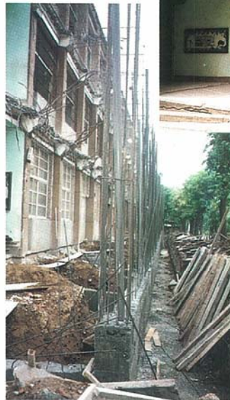
南園樓走廊 拆除後整建中
