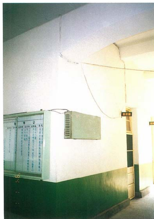
花園樓中川堂東半壁面整修後
