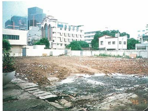
小木造禮堂拆除後現場
