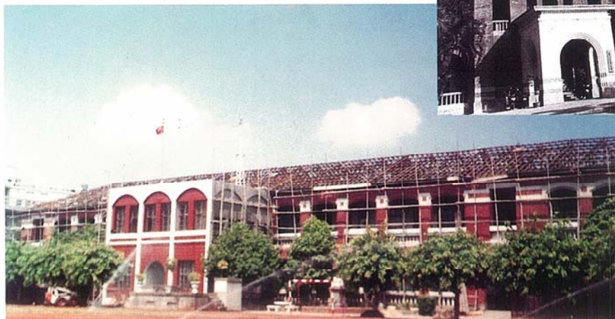
花園樓79年整修 屋頂
