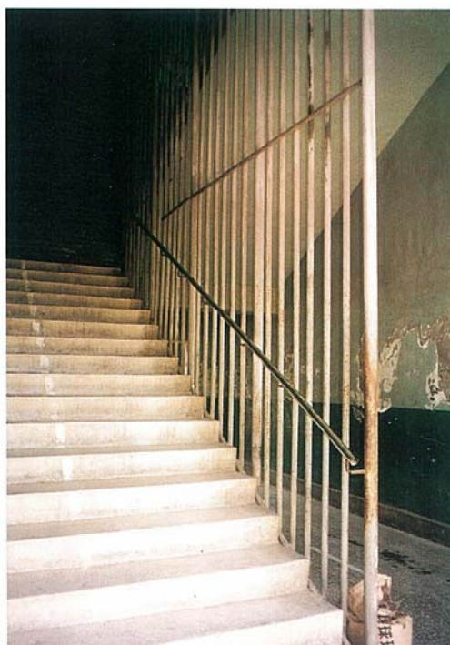
花園樓南樓梯整修前
