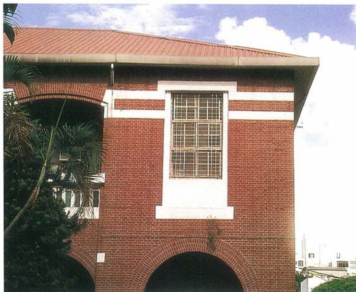
公園國小花園樓南側樓梯間
