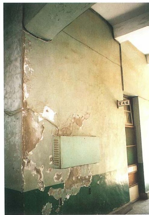
花園樓中川堂東半壁面整修前
