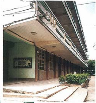
南園樓整修前 ▶
