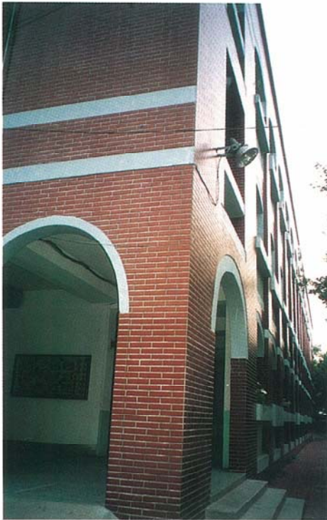
南園樓整修後
