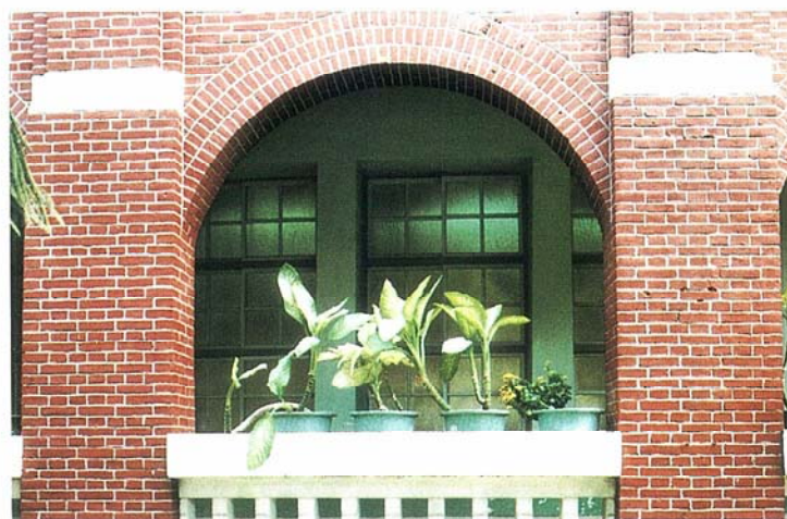
公園國小花園樓一樓拱圈細部
