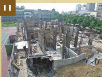
一樓牆柱梁模版組立
