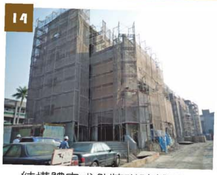
結構體完成外牆磁磚鋪設
