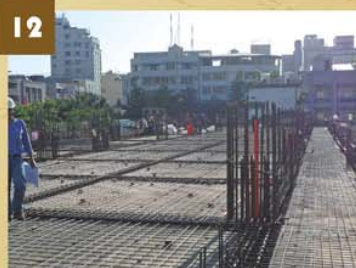
二樓底版鋼筋綁紮
