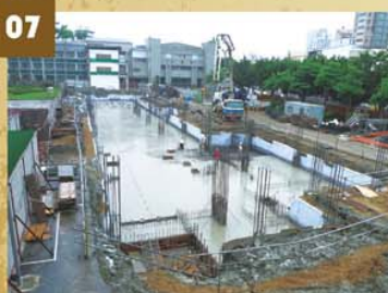
地下室版基澆置完成
