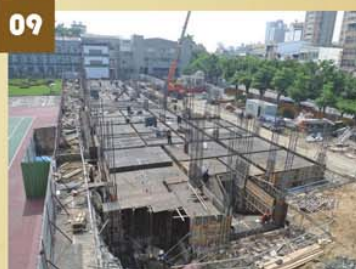
牆柱梁模版組立完成
