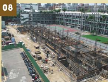
牆柱梁模版組立
