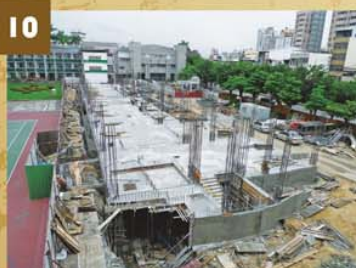
一樓底版灌漿完成
