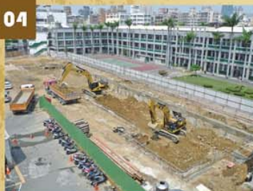
地下室開挖及擋土牆施作
