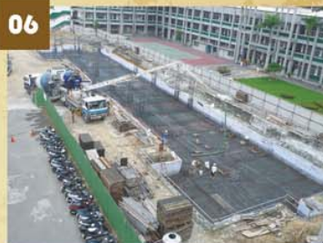
地下室版基鋼筋綁紮完成
