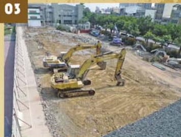
拆除後基地整地完成
