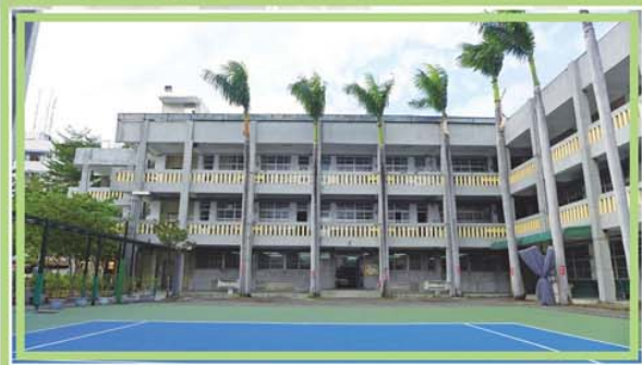
第二棟-活力樓
