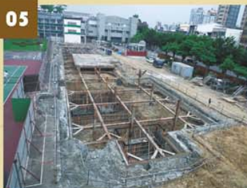
地下室架設水平支撐工程完成
