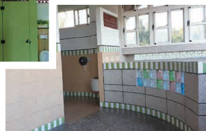
◀ 105年8月篤信樓廁所修繕更新
