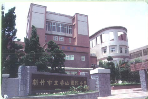
▼92年-頂樓三角造型牆因921地震後造成 傾斜有安全顧慮而拆除
