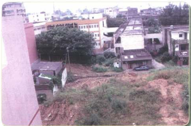
▼ 87年-綜合球場舊景(民宅尚未拆除整地)
