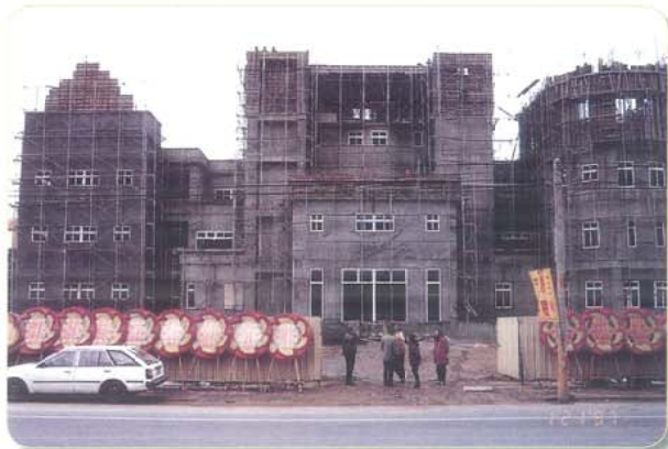
▼86年-觀景台施工
