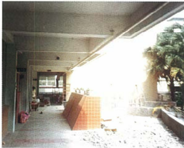
▲修繕幼稚園走廊。
