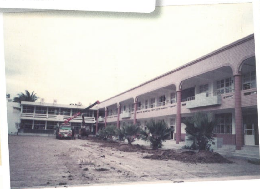
教室重建工程
