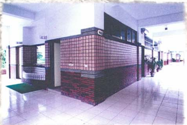
新建校舍走廊、廁所 (86年)
