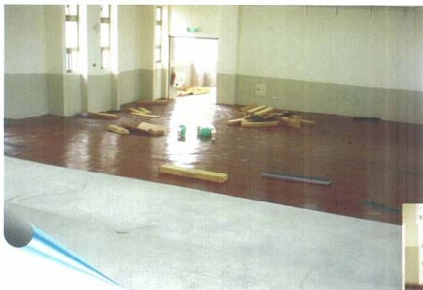
地板磚鋪設工程
