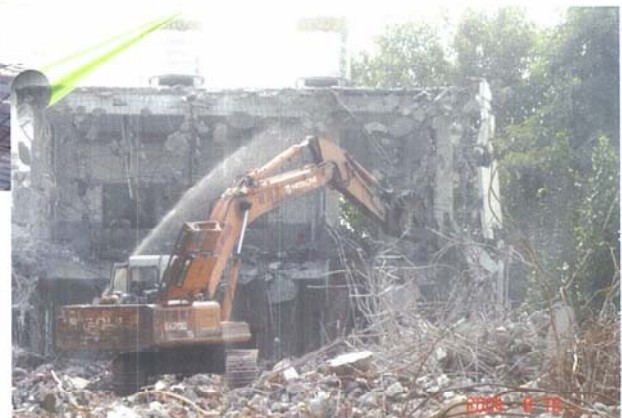
老舊校舍拆除過程
