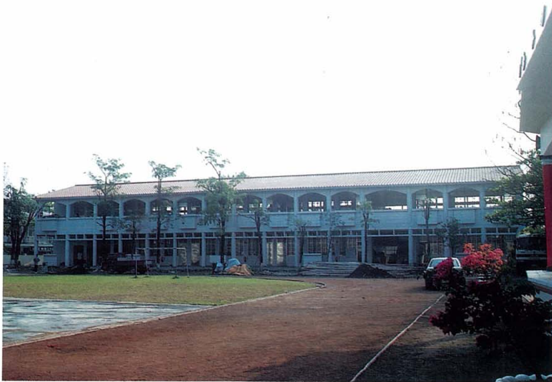
◎89年4月完工之新建教室
