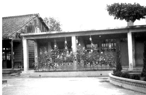
相2-3-9 原校舍檔案照片 (4) 〈由照片研判該屬拆除木造教室改建RC構造教室〉
