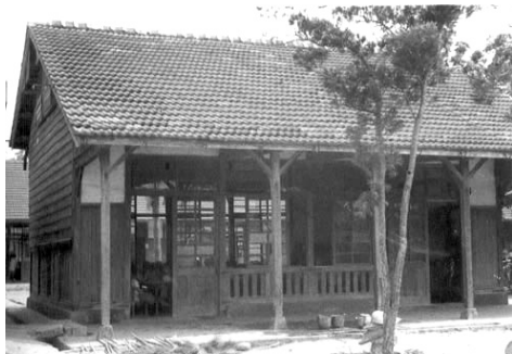
相2-3-4 日治時期木造瓦葺教室 (1)
