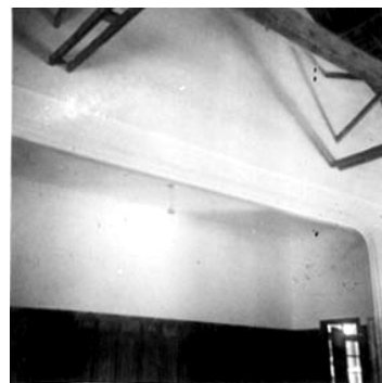
相2-4-16 民國74年整修完成之檔案照片(3) 〈舞台區木板夾泥牆修復〉
