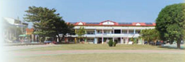
109年度教學大樓耐震補強完成
