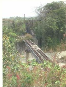
糖鐵穿越急水溪堤防舊照
