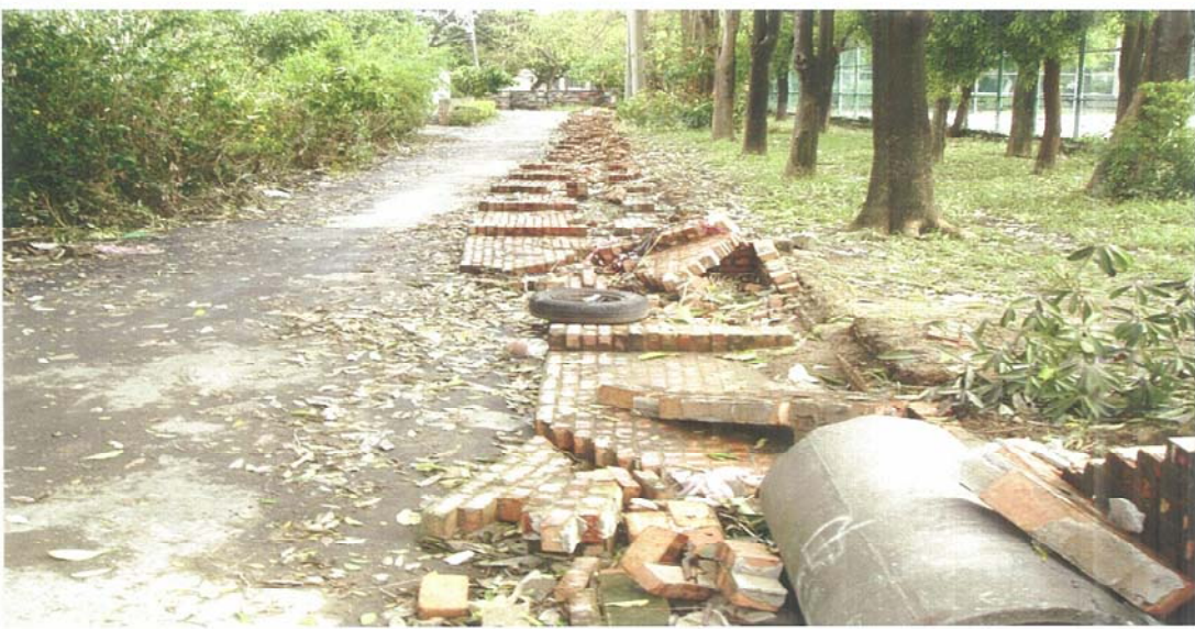
西南邊80公尺的圍牆，平躺泣訴災情。
