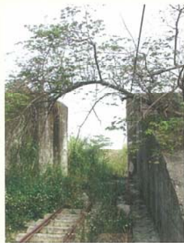
糖鐵穿越急水溪堤防
