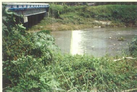
將軍溪源頭十五孔涵洞現況
