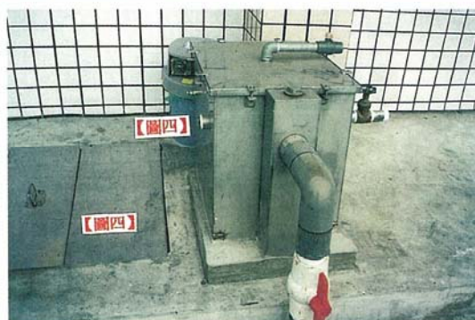
【圖四】自動生化除臭處理及吸式幫浦
