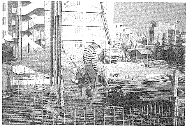
〈結構體混凝土澆注〉
