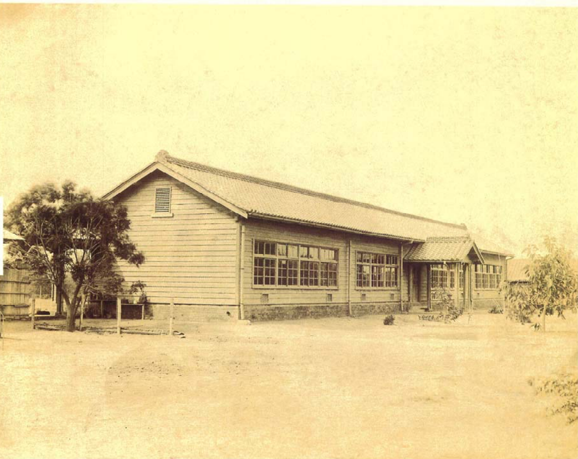
西側第一棟教室
