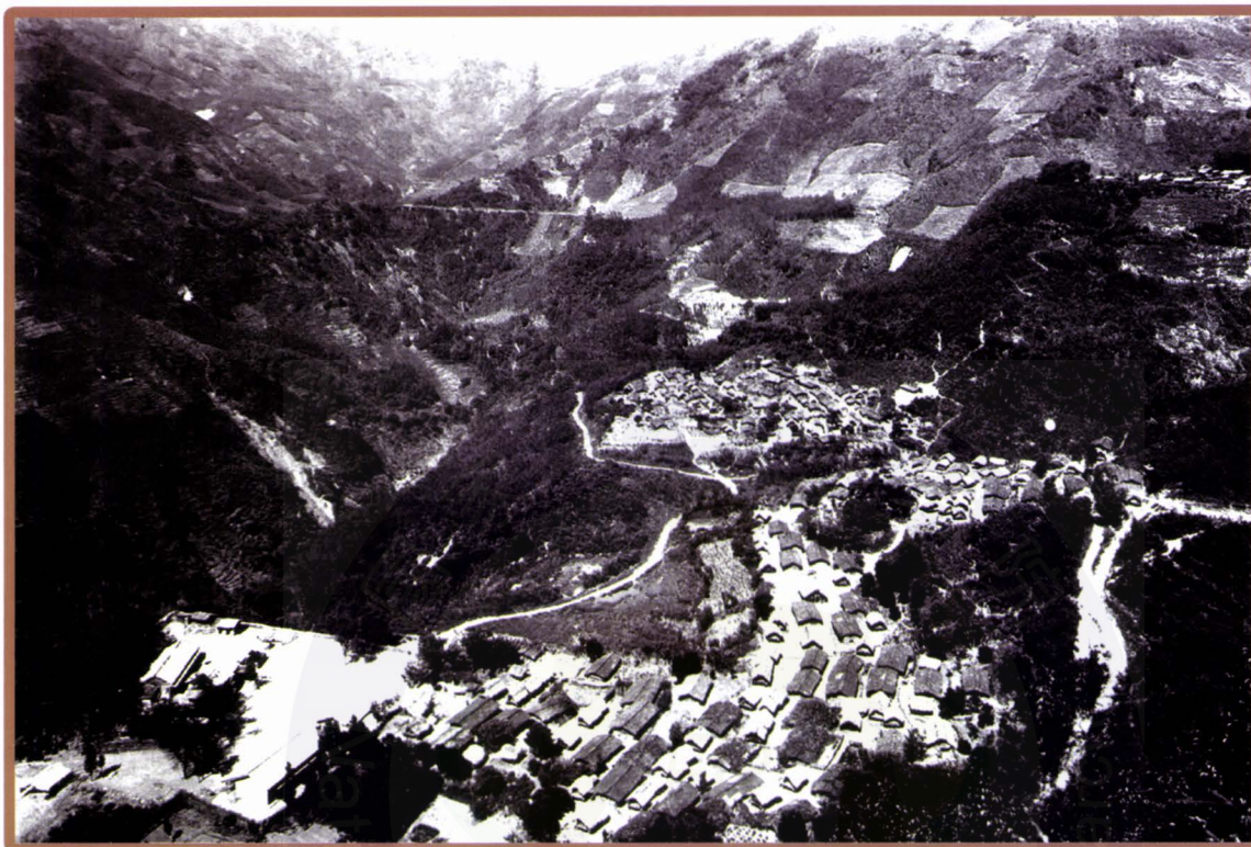
1930前 TODA部落全景
