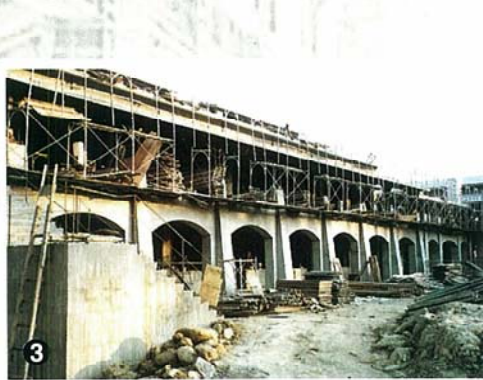
③ 一樓水泥澆灌完成。
