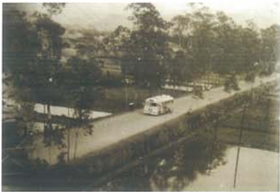
▶ 從崎下到基督教山地中心診所的道路
