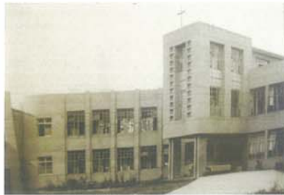
▶ 921 地震震毀的舊醫療大樓
