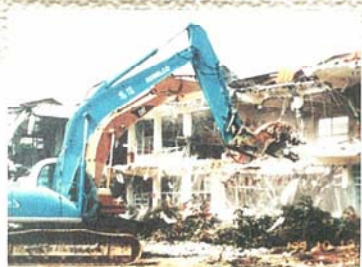
九二一地震後拆除倒塌建築物
