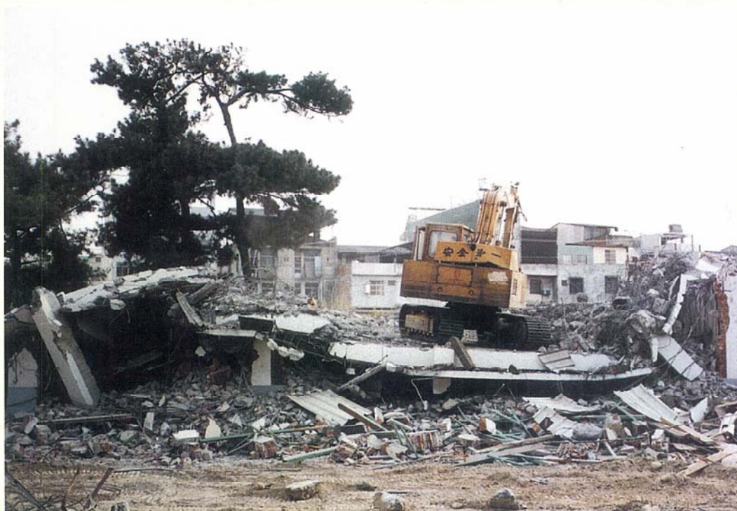
正在拆除中的南棟教室。
