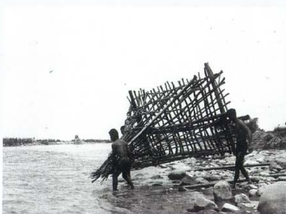
■穩定舊濁水溪分水嶺的竹籠
