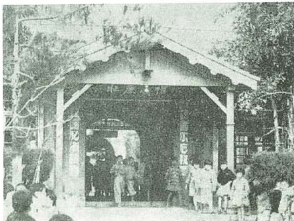
▲ 舊貌〈民國50年以前之中庭穿廊〉
