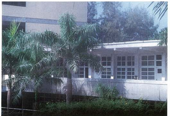
▲二樓教室及走廊（86年4月外觀整飾前）
