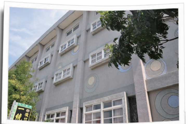
活動中心外牆整修
