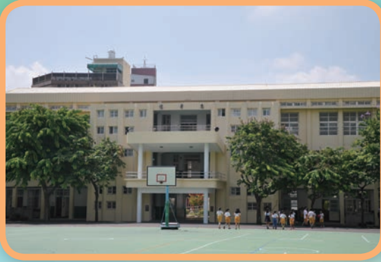
忠孝樓重新粉刷工程
