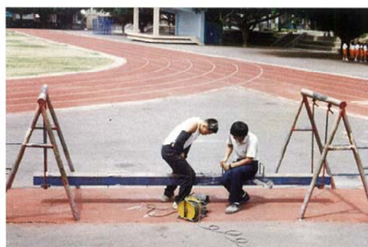
定期維修遊戲器材
