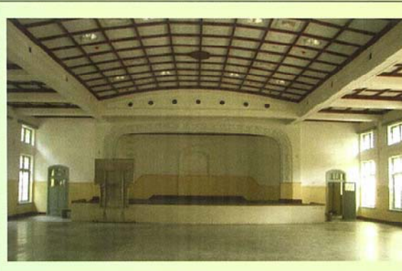
大禮堂室內-施工後(由西向入口往講堂拍攝)復原講台立柱，恢復其源由泥塑樣式與藝術假樑。
