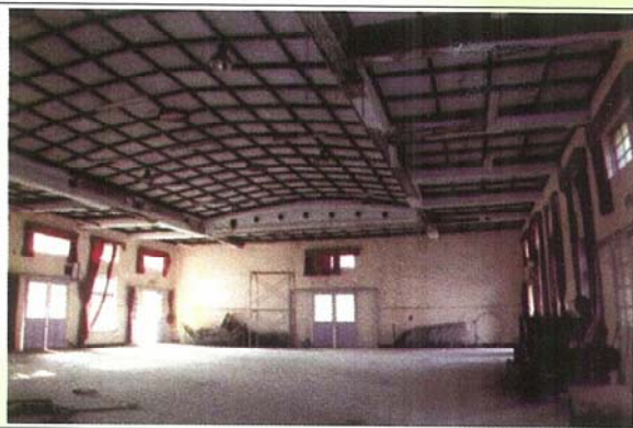
九二一地震後禮堂內部一 來源：翻拍自「台中縣歷史建築清水國小調查研究與修復計畫」報告書
