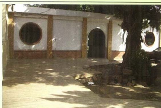
禮堂南面-施工後 新作木平台
