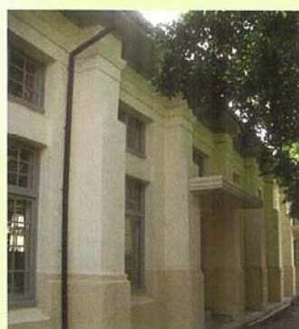
大禮堂北面-施工後
