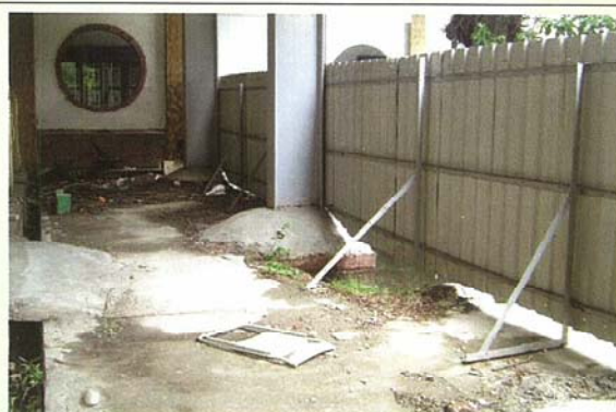
禮堂南面-施工前 原有地坪為水泥粉光
