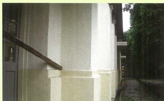
大禮堂北面-施工後
