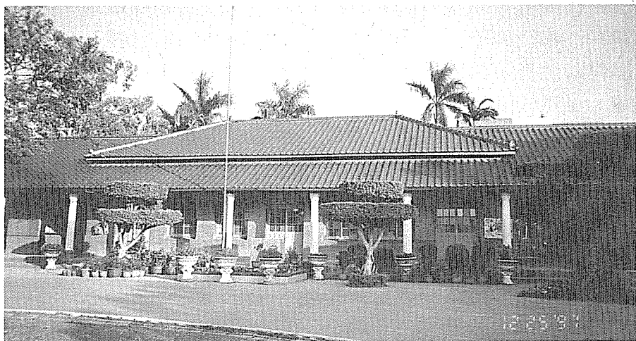
照片88 由大操場向東拍辦公室的屋頂
