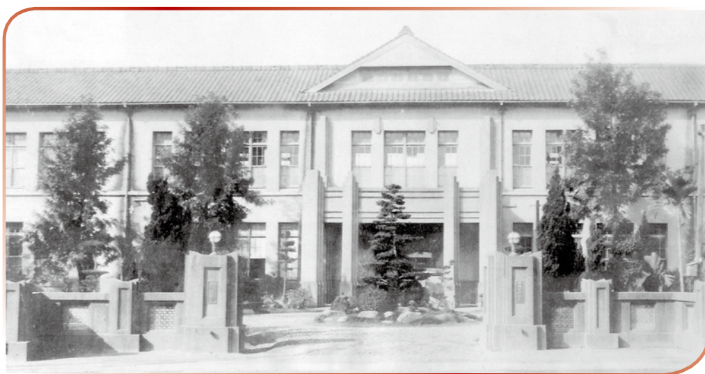
■民國 23 年 11 月新建校舍落成後遷入上課 (現已拆除，就在西安街與中興路之間的中山路段)
