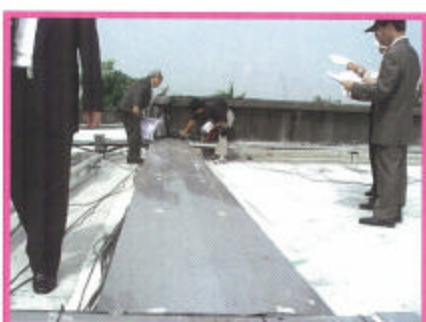
● 教學大樓頂樓防水工程95.2
