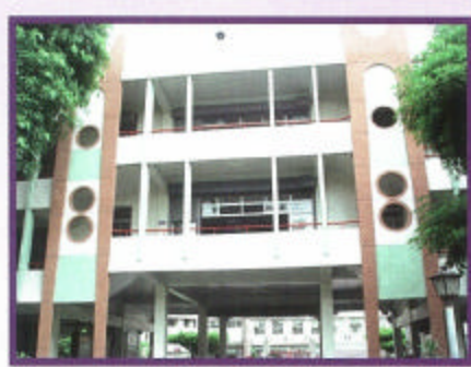
● 牆面整修工程95.8
