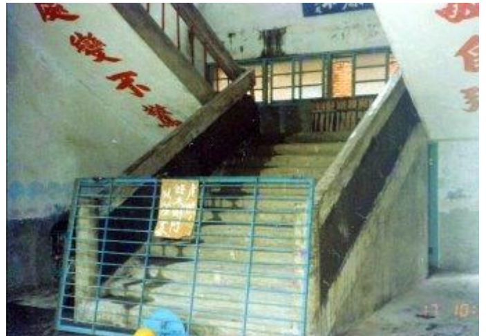
二樓施工中，禁止進止囉
