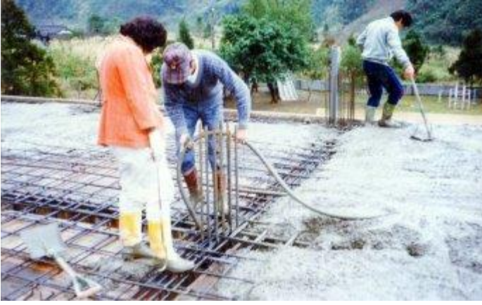
廚房增建之施工
