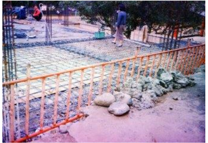
廚房增建之施工
