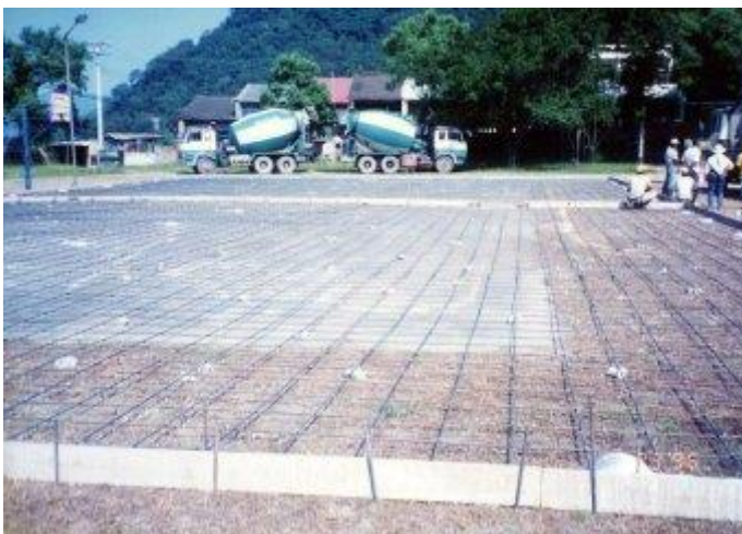
球場地面施工中
