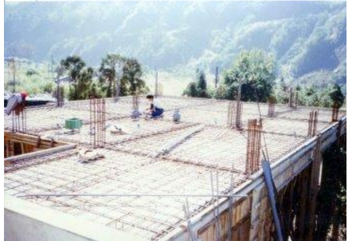
廚房增建之施工
