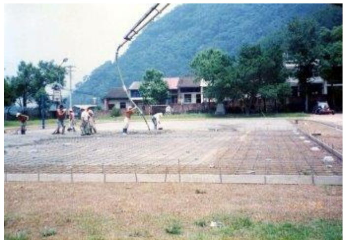
球場地面施工中
