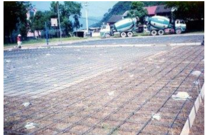
球場地面施工中
