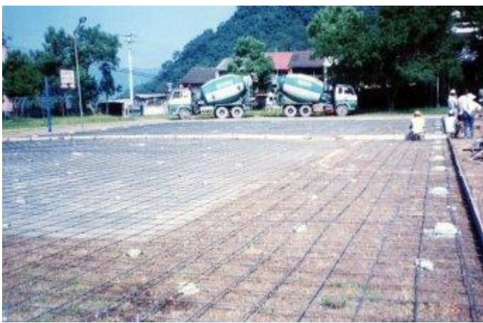
球場地面施工中
