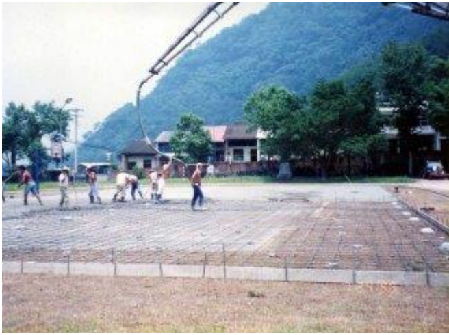
球場地面施工中
