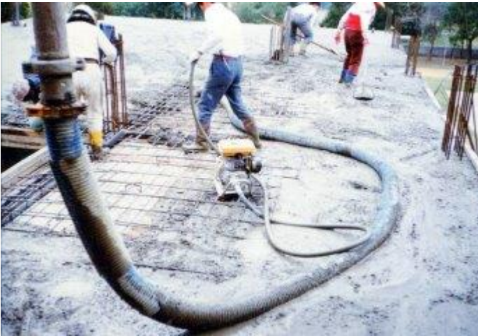
廚房增建之施工
