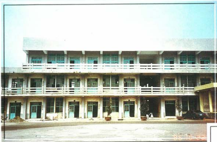
▲ 第一棟教室增建三樓完工
