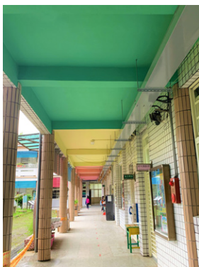
走廊天花板及線槽油漆工程
