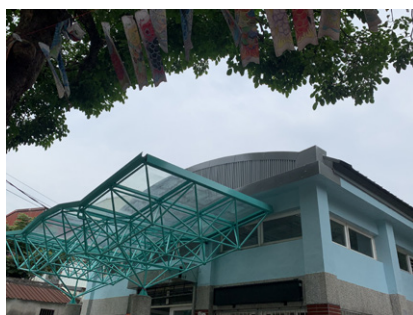
活動中心整修工程
