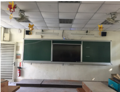
智慧教室觸屏工程
