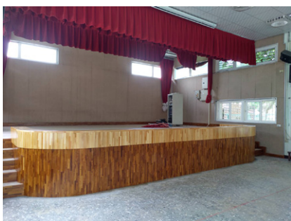
活動中心舞台整修工程
