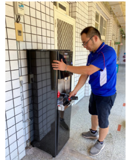
飲水機增設工程
