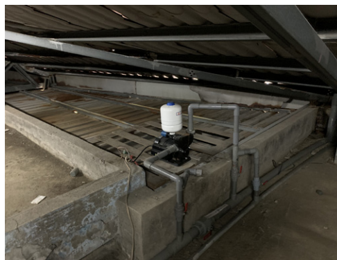
第三棟頂樓防水隔熱工程
