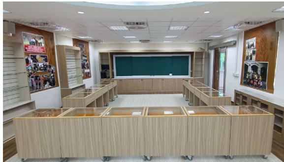
校史室整修工程
