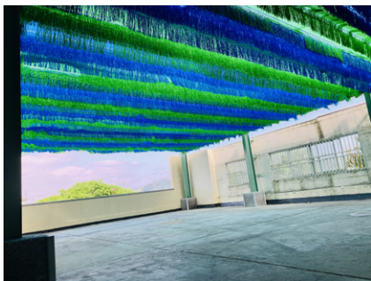
第三棟右側屋頂鋼架工程
