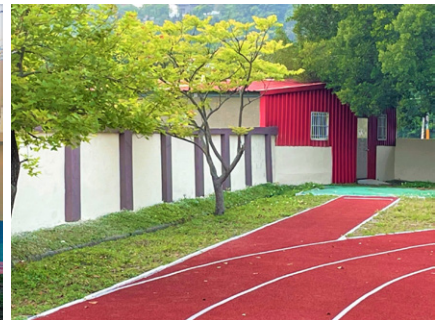
操場 PU 跑道整修工程暨圍牆 粉刷工程
