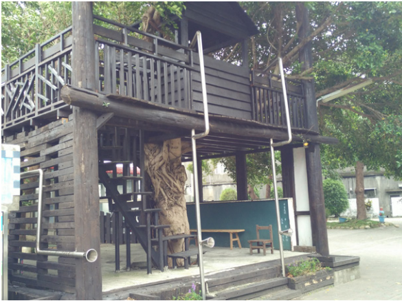
樹屋整修工程
