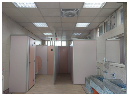
廁所整修工程
