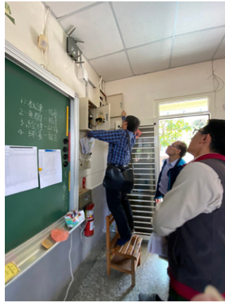
冷氣電力改善工程
