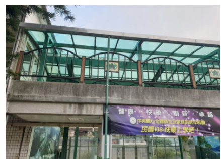
正門口防水隔熱工程
