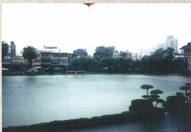
未整建、重建前操場積水不退
