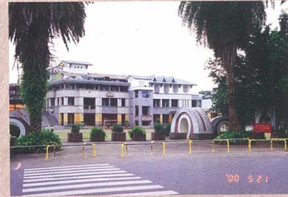
為排除操場積水整建時填高60公分
