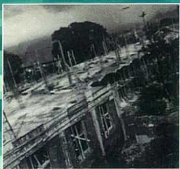
興建中の二棟教室
