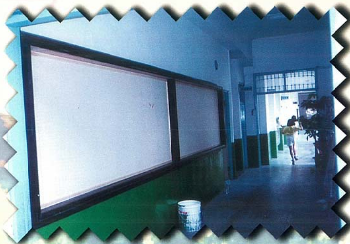
迎接百年慶，校史室施工中
