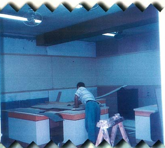
迎接百年慶，校史室施工中
