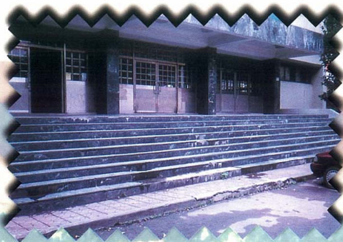
學生活動中心修繕前
