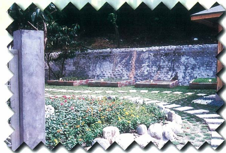
生態教材園護坡完成
