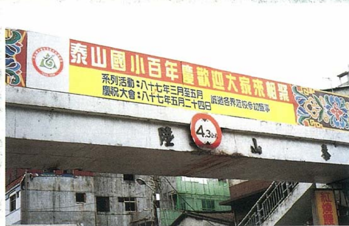
架設在「泰山陸橋」上的巨型看板
