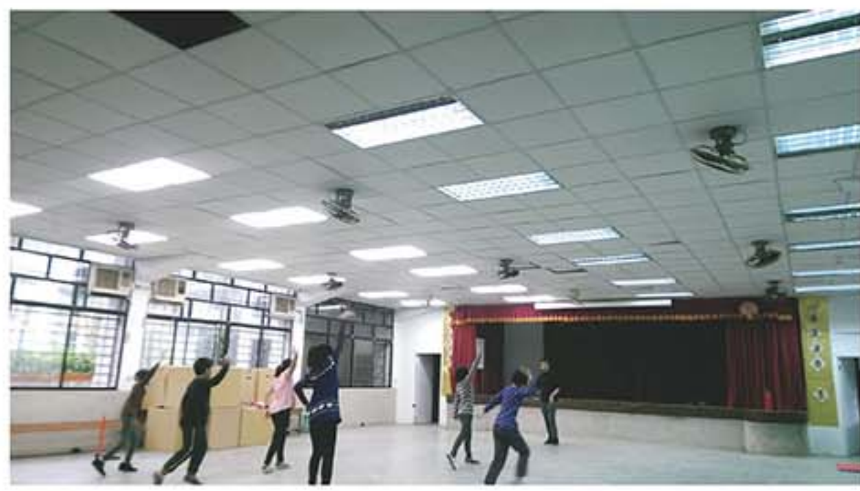
更換活動中心及走廊燈具為 CCFL 節能燈具，燈管省電效率達 70% 的效果，場地更加明亮，學生學習更有效率。
