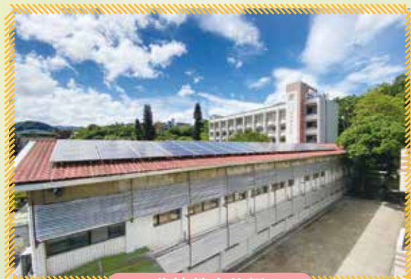
北棟教室後側
